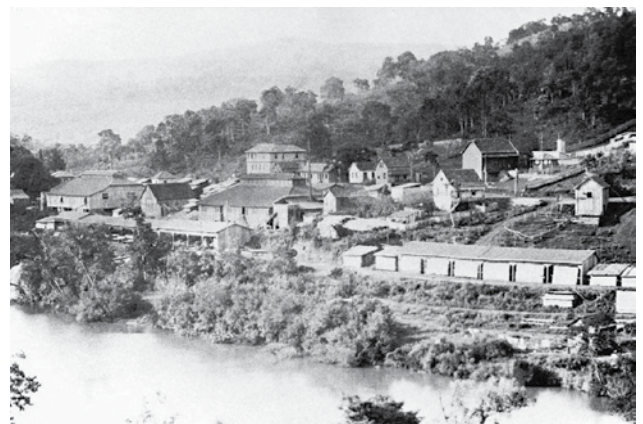
Vista geral da Indústria de Madeiras Rio Bonito Ltda. Rio Bonito, 1944
